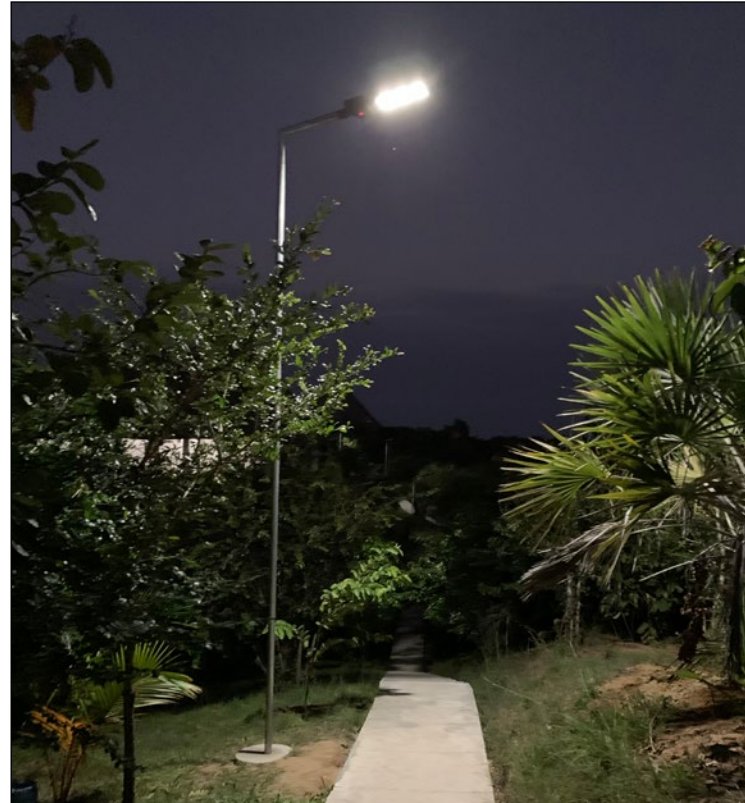
Alamedas iluminadas para maior segurança
